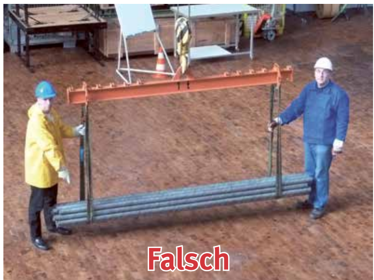
Bild 5-15: Beine der Anschläger befinden sich im Gefahrenbereich
