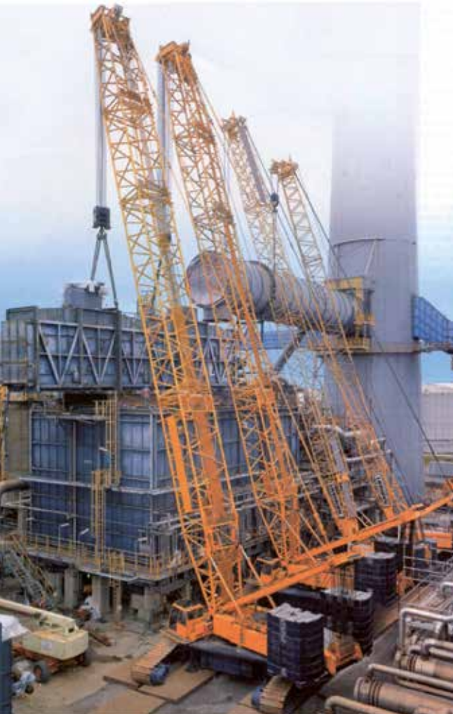
Bild 6-1: Zusammenarbeit von vier Kranen
