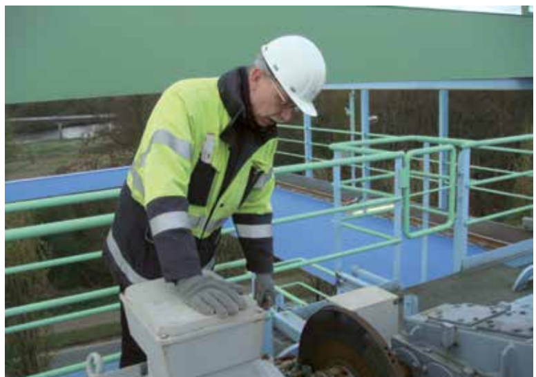
Bild 4-6: Der Kranführer nimmt die Bremse in Augenschein
