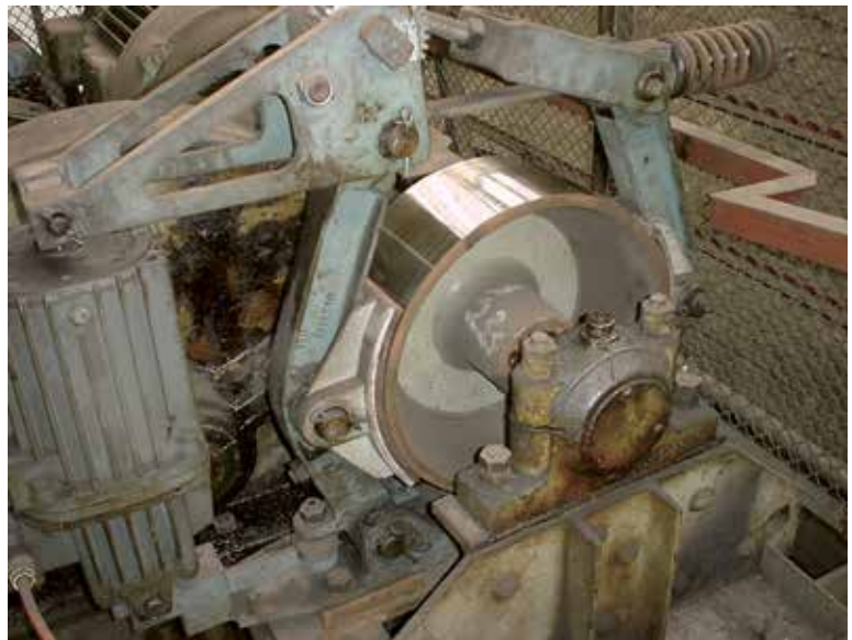
Bild 4-4: Inaugenscheinnahme einer Trommelbremse
